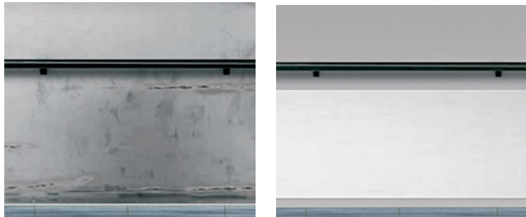
Pared sin protección. Pared con protección.
